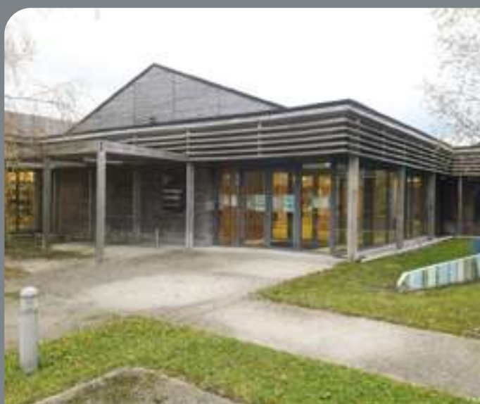
FINISTÈRE Bibliothèque départementale
